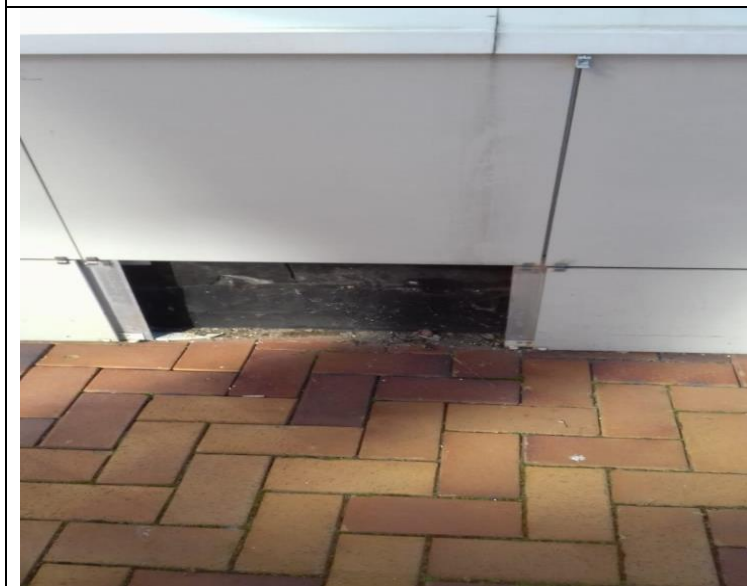
Кор.4, эт.1 Территория Вентилируемый фасад -установка фасадной плитки
