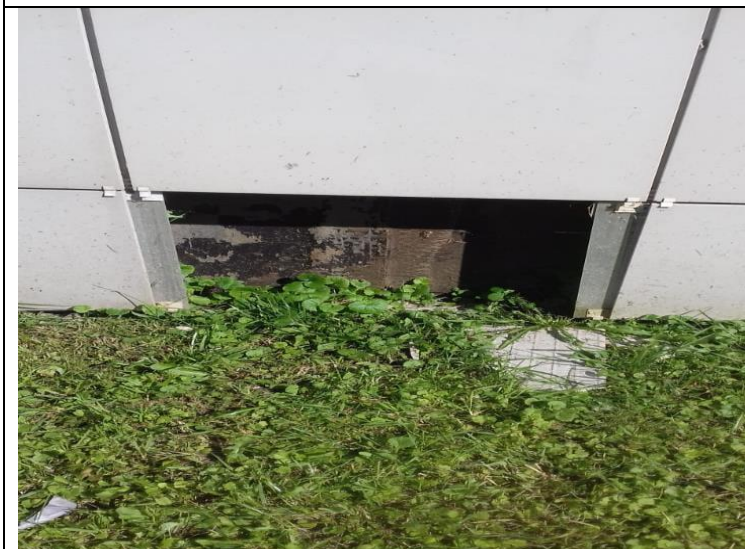
Кор.4, эт.1 Территория Вентилируемый фасад -установка фасадной плитки
