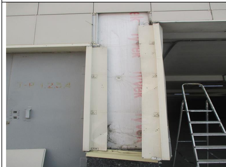
Кор.4, эт.1 Въезд в паркинг Вентилируемый фасад -установка фасадной плитки
