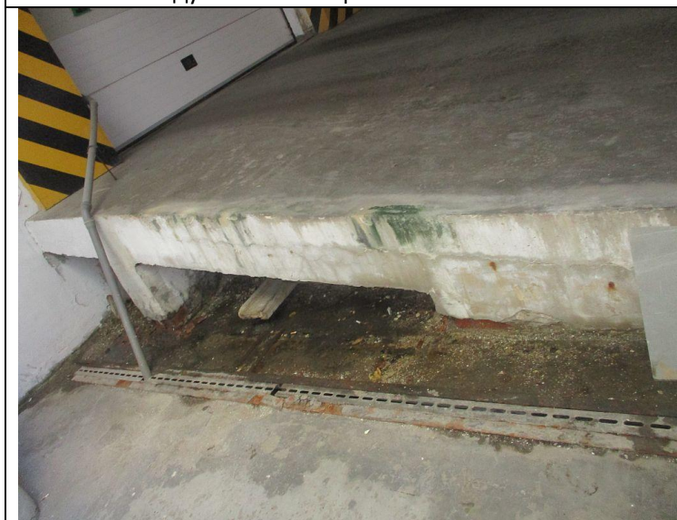
Кор.1, эт.-1 Заглубленный проезд Обшивка пандуса листами ЦСП -подготовка поверхности -обшивка пандуса листами ЦСП
