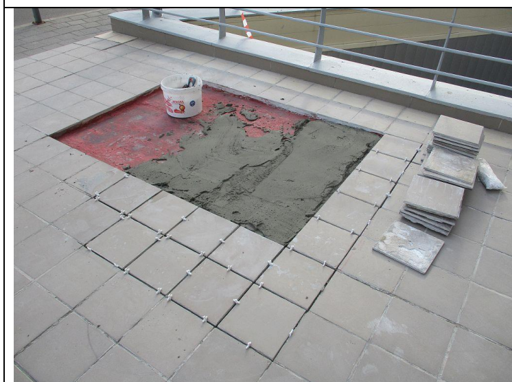
Кор.5, Сек.2-3 эт.1 Территория Ремонт напольной плитки -подготовка поверхности -укладка плитки
